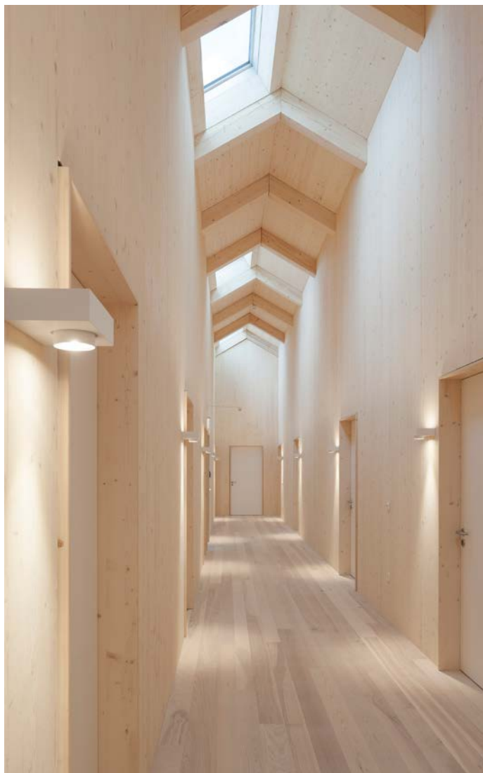
Abbildung 2: Im Flur und Treppenhaus sind »One Piece 8«-Wandleuchten in Sonderanfertigung verbaut.
